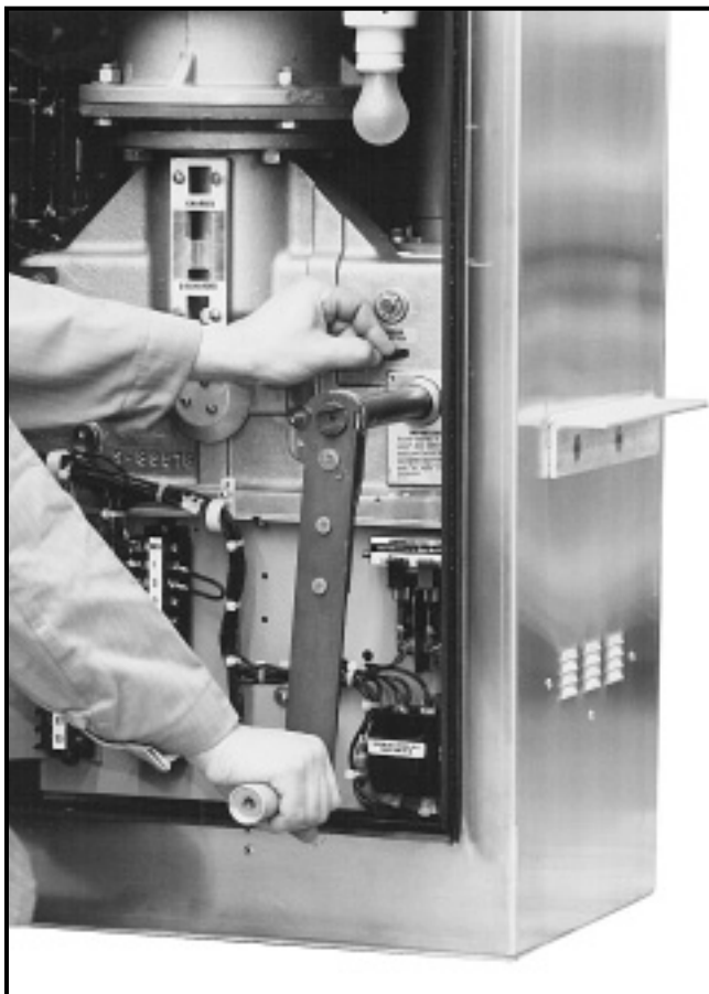
Figura 19. Usando la manivela de carga manual para recargar resortes de apertura y cierre, y abrir el seccionador.
