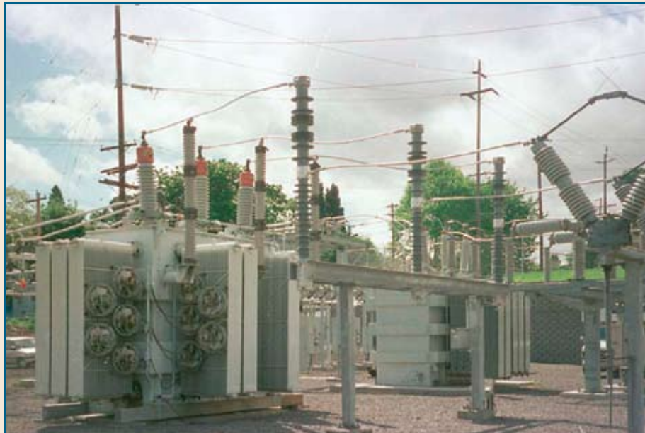
Instalación Terminada del Trans-Rupter II Modelo EX de 115 kV.
