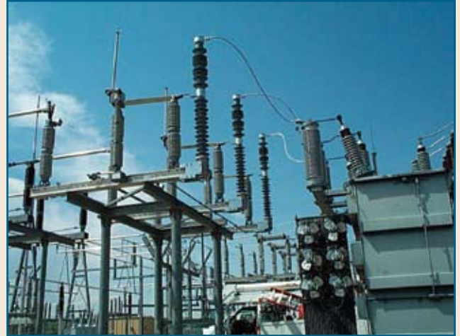
Paquete de modernización con un Trans-Rupter II instalado en una base ya existente de un Circuit-Switcher Mark II
