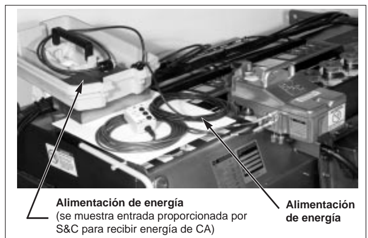
Figura 9. Conectando el cable de alimentación de energía.
