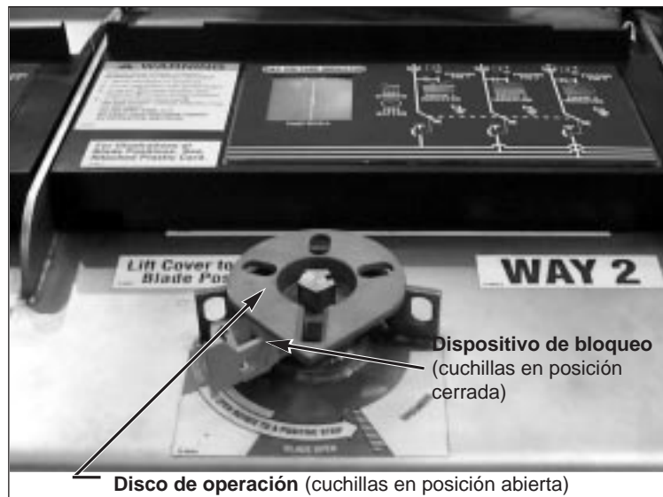
Figura 2. Dispositivo de bloqueo para las cuchillas en posición de cerrado.
