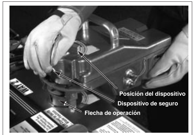
Figura 4. Colocando el moto-operador portátil sobre la flecha de operación.
