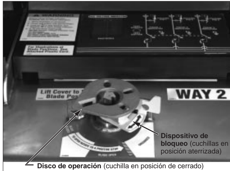
Figura 1. Observe la posición del disco de operación y el Dispositivo de bloqueo.
